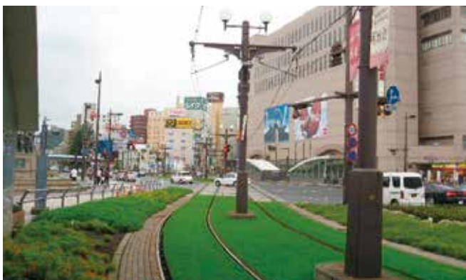
【写真2】中央駅付近の軌道緑化
