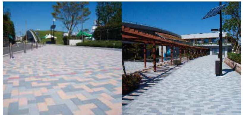
【写真5】廃棄物を混合したインターロッキングブロック
