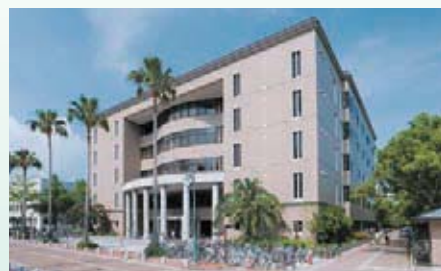
▲1996年 平成8年12月)新中央図書館竣工。今年5月には1階アトリウムをギャラリーとして整備し、11月には歴史展示室も併設
