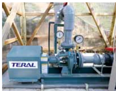
小水力発電装置。真ん中の配管を通った水が羽根車を回し、その動力を利用して左の発電機が電気を出力する
