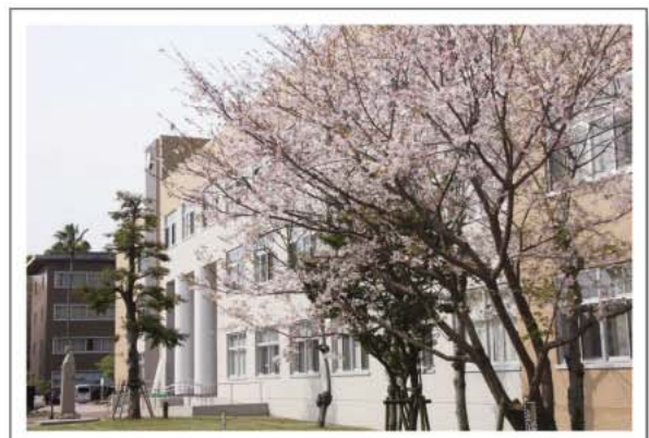
農学部共通棟
