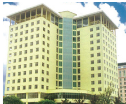
▲この建物の11階に事務所が入っている
