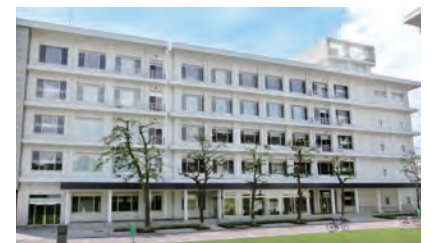
▲共通教育棟1号館
