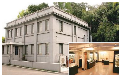
▲常設展示室外観
