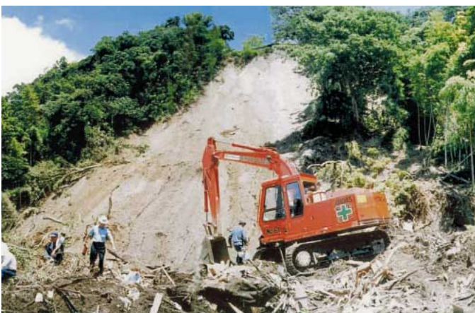
図1 シラス斜面の崩壊
