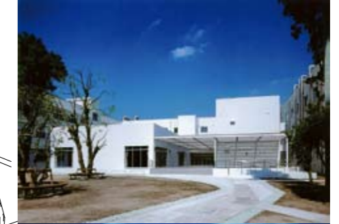
改修：農学部共通管理棟（補助金（PFI））
