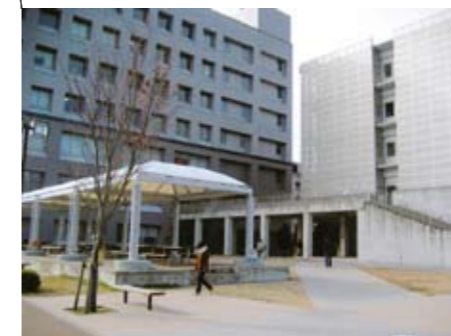
総合教育研究棟北側
