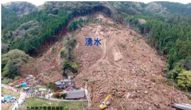
【図3】2018年4月11日に大分県耶馬溪町で発生した土砂災害
