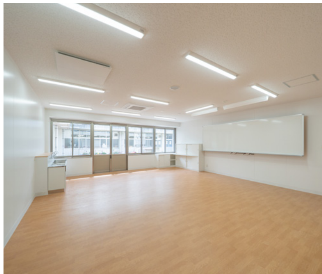
▲ 全熱交換器、LED 照明を採用した教室
