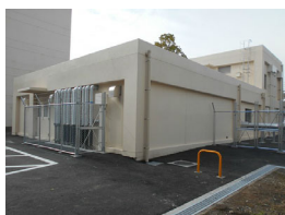
⑦ ポンプ室
