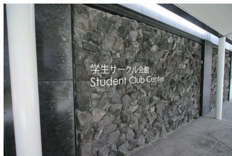
旧建物外壁(火山岩)の再利用 (記憶の継承:既設建物等の装飾を活かした計画)
