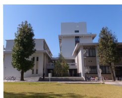
② 建築学科1号棟・2号棟
