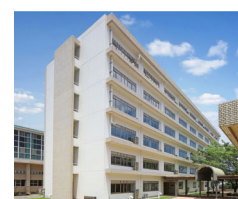
⑧ 管理棟・理系研究棟
