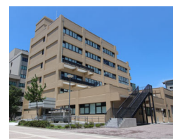
④ 海洋土木工学棟
