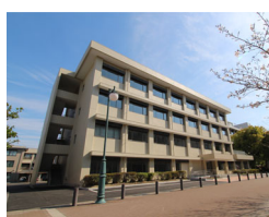
⑥ 機械工学2号棟
