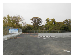
ポンプ室周辺
