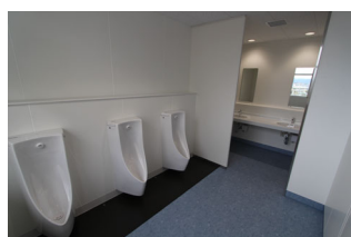
アメニティの改善 (トイレ改修)
