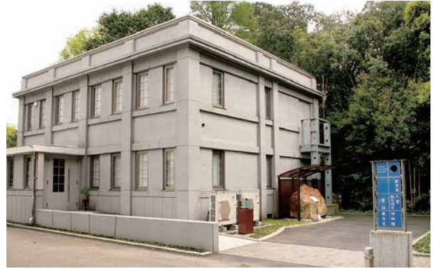
▲常設展示室外観
