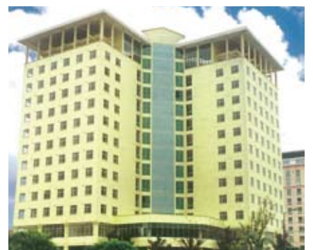
▲この建物の11階に事務所が入っている
