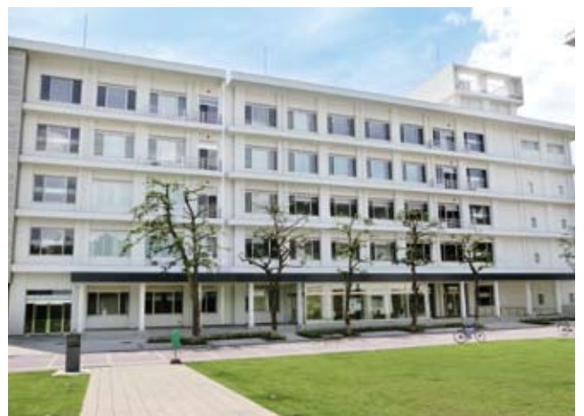
▲共通教育棟1号館
