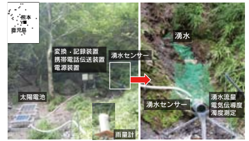
▲湧水センサーによる深層崩壊警戒対応に関する現地試験（熊本県五木村）
