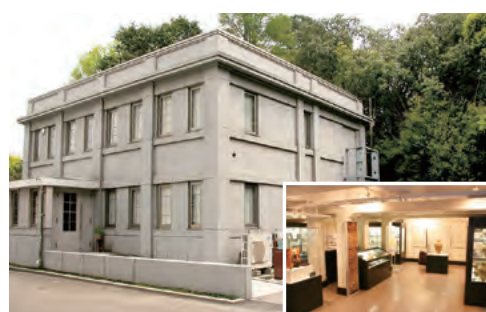
▲常設展示室外観
