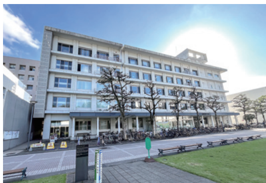
▲共通教育棟1号館
