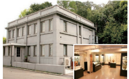
▲常設展示室外観
