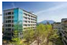
『SARF-Kagoshima』理工系総合研究棟1階に設置中!!
