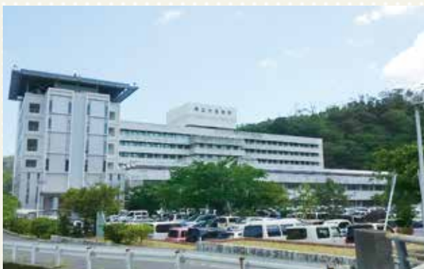
写真2. 鹿児島県立大島病院全景 (左部分は今年新設されたヘリポート併設の救命救急センター)
