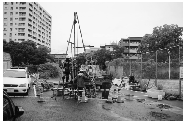
PL. 14 保育所建設予定地ボーリング調査 (No. 1)
