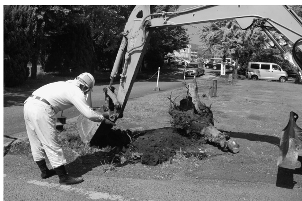
PL. 2 2017-C c 地点樹木撤去状況
