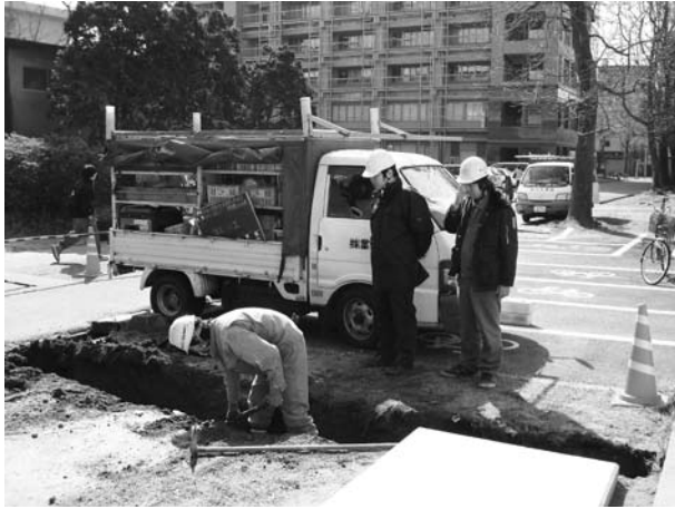
17 2008-K K1 掘削状況
