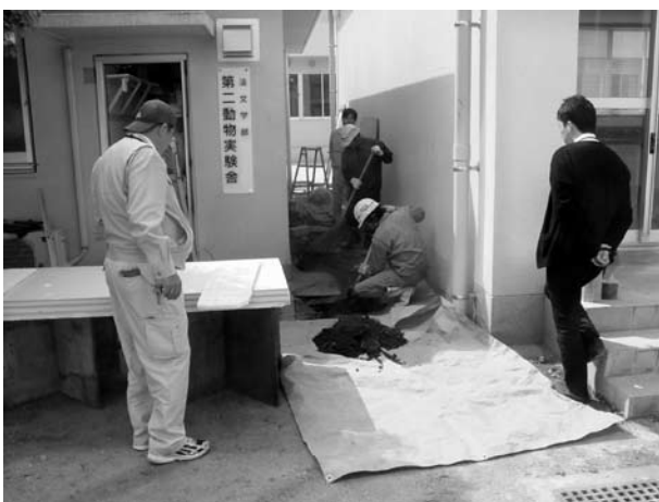
21 2008-L 掘削状況
