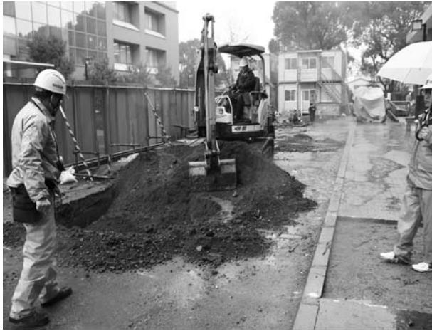
11 2008-F F10 付近掘削状況
