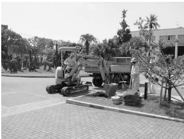
1 2008-A A1 地点掘削状況
