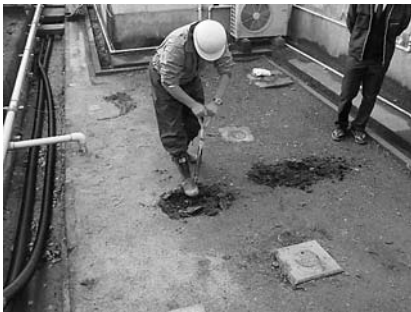
1 No.1 トレンチ掘削状況
