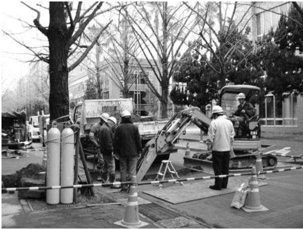
19 2008-K K2 地点掘削状況
