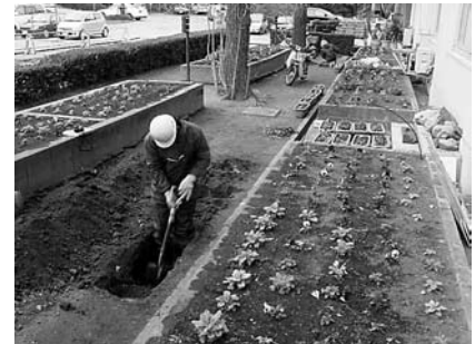
8 No.4・5 トレンチ掘削状況
