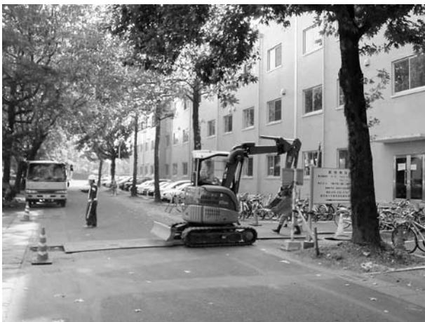
9 2008-E 掘削状況
