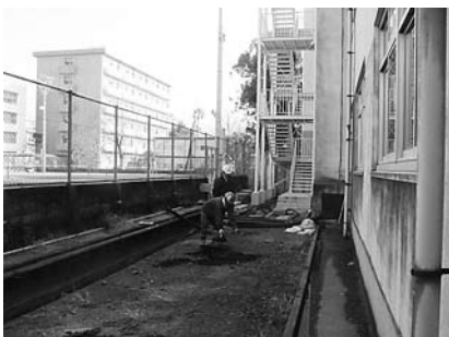
5 No.3 トレンチ掘削状況
