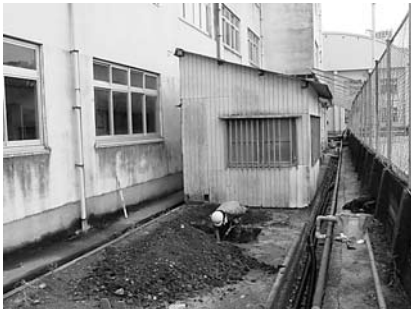
3 No.2 トレンチ掘削状況
