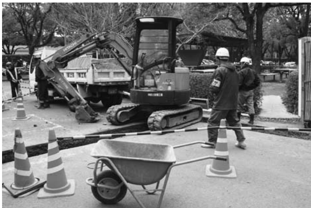
15 2008-F F14・15 付近掘削状況
