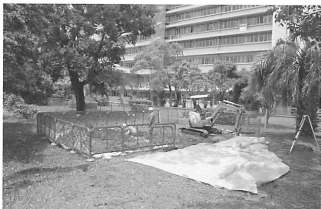
No.7トレンチ位置(東より)
