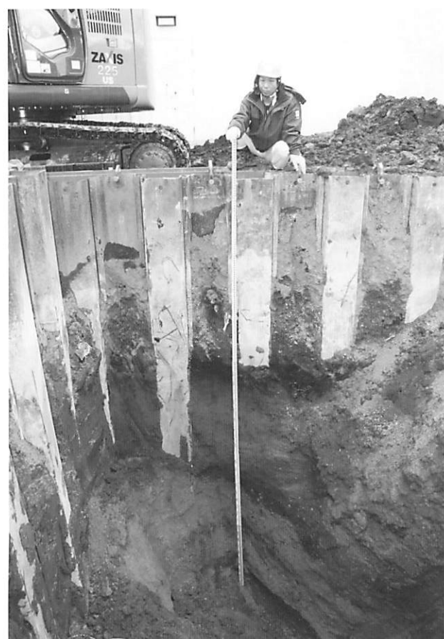
PL.79 2011-J C 地点南側北壁 (工事中確認)
