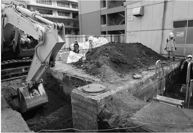
1 浄化槽周辺攪乱層の掘削 (工程 [1])
