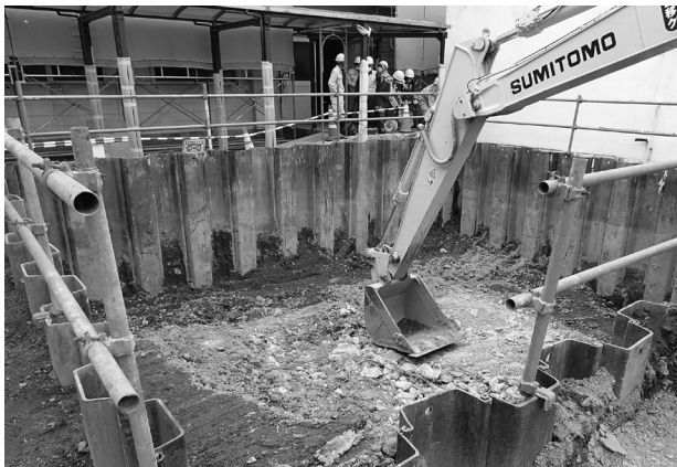
4 浄化槽上部解体とシートパイル設置完了 (工程 [2] [3])
