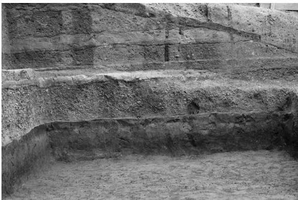
3 1区東壁下部（西から）
