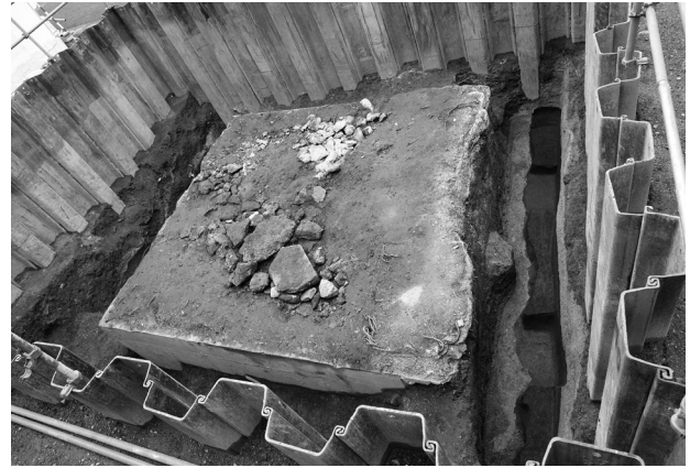
3 完掘状況 南東部から (工程 [5])
