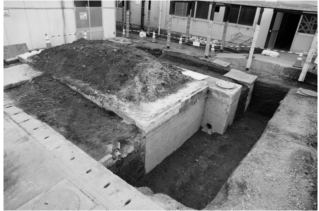
2 浄化槽周辺地表下 1.5m まで掘削 (工程 [1])
