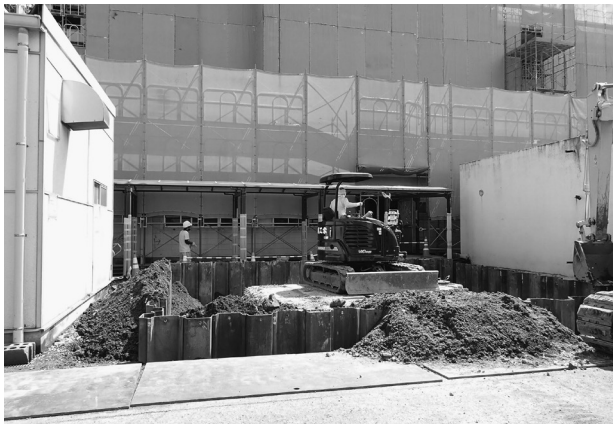
3 浄化槽上部解体とシートパイル設置 (工程 [2] [3])
