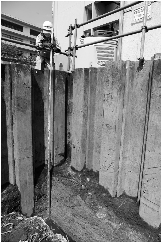
2 東壁北側 土層残存状況 (工程 [5])
