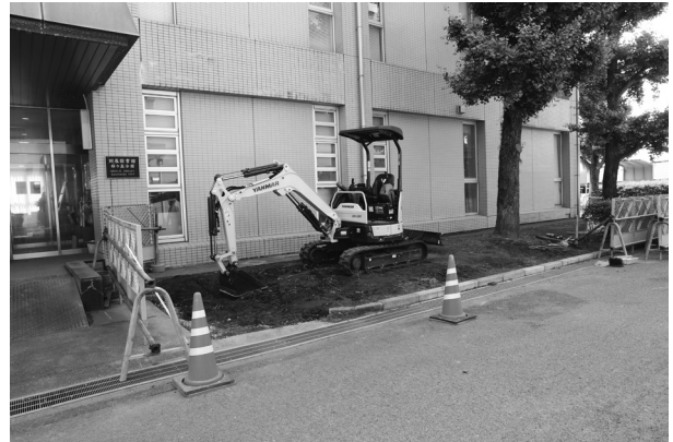
4 2区表土掘削前（西から）
