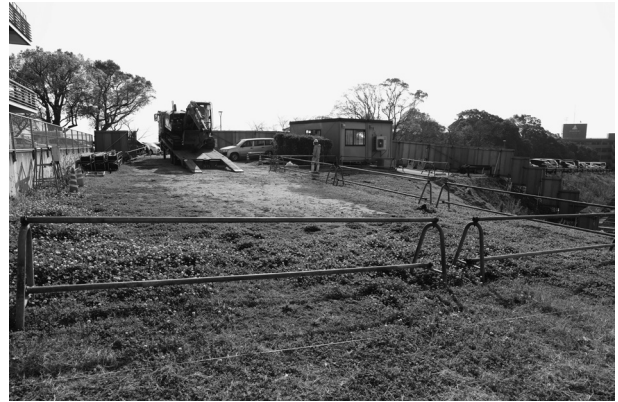
2 調査前（西から）
