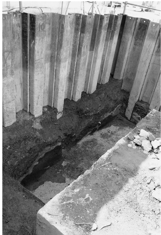
5 浄化槽周辺掘削完了, 西壁 (工程 [4])
