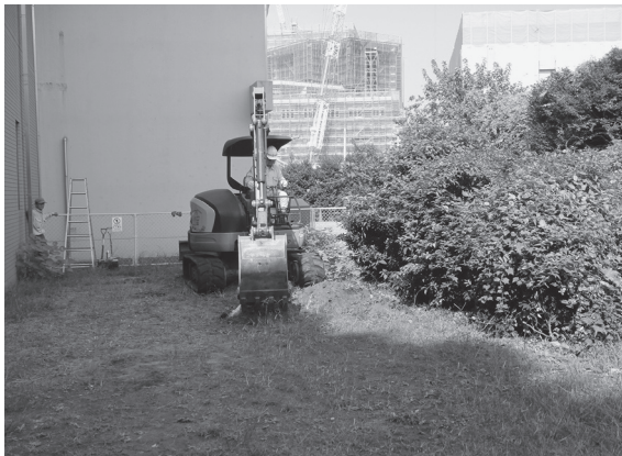
2014-J a 地点掘削状況
