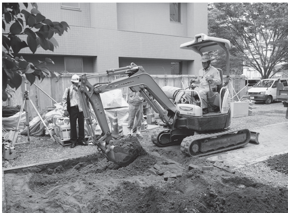
2014-C 東側電柱掘削状況
