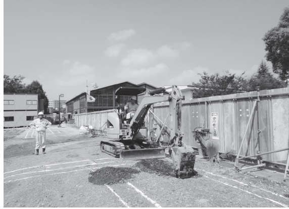
2014-B e地点掘削状況
