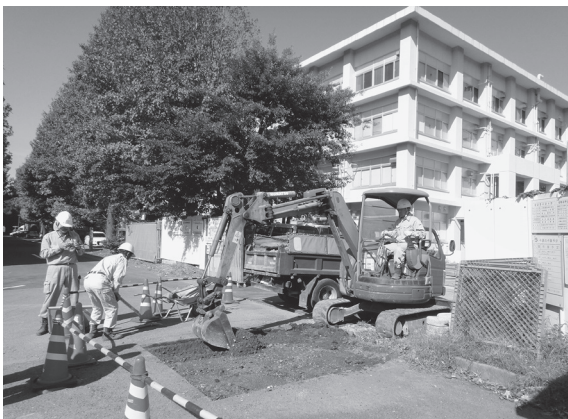
2014-H b地点掘削状況
