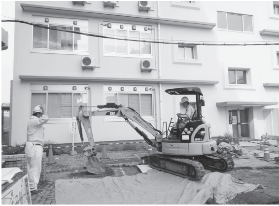
2014-B h地点 掘削状況
