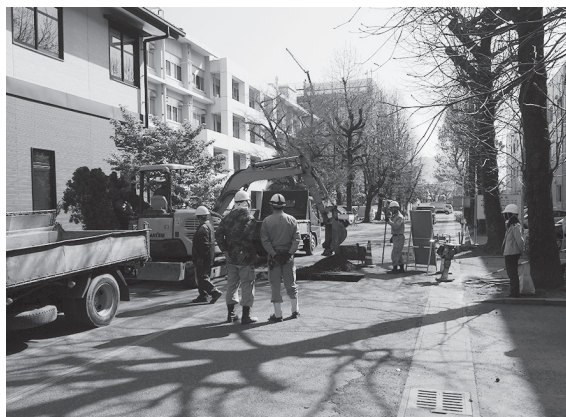
2014-H d地点 掘削地点
