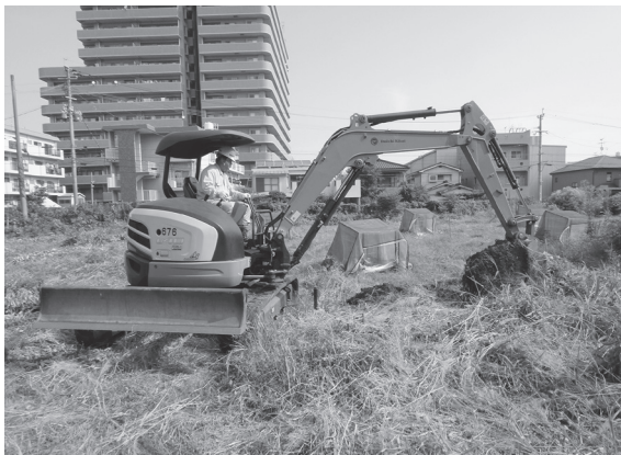
2014-J b 地点掘削状況
