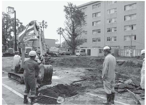
2014-B b地点 掘削状況
