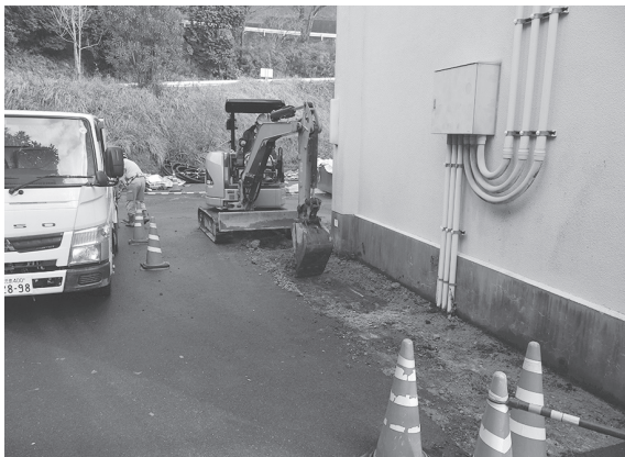
2014-M b 地点掘削地点
