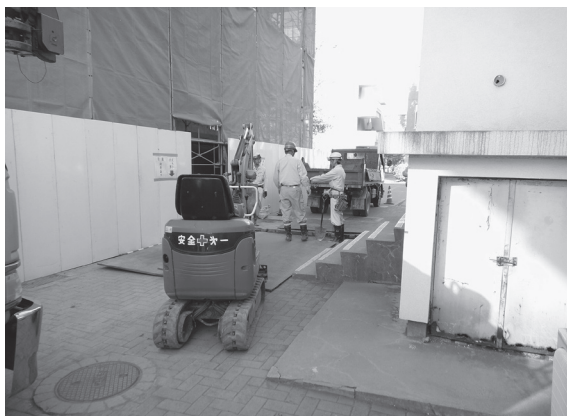
2014-F d地点掘削
