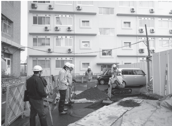
2014-B l地点 掘削状況
