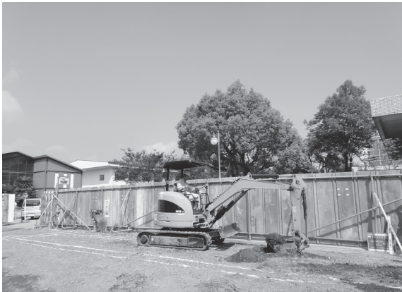
2014-B f地点掘削状況
