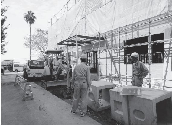
2014-B d地点掘削状況 北より
