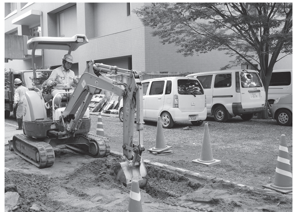
2014-C 西側電柱掘削状況
