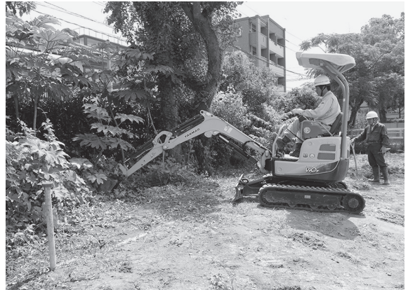
2014-D b地点 移植先掘削
