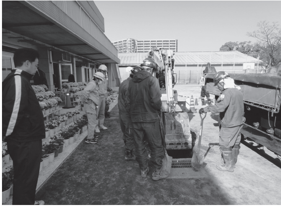
2014-I a 地点掘削状況
