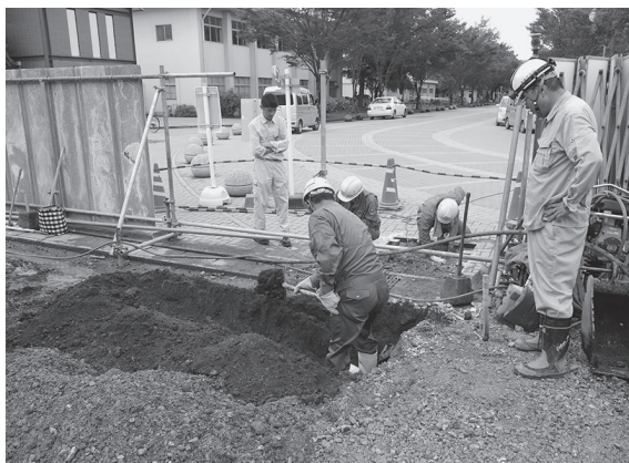
2014-B c地点 掘削状況
