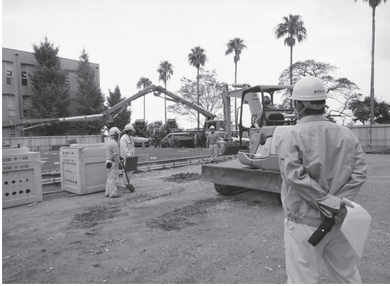
2014-G a地点 掘削地点
