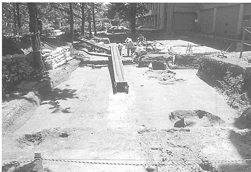
PL.16 作業の様子（西から）
