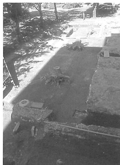
PL.17 D地点II 2層検出状況（南西から）
