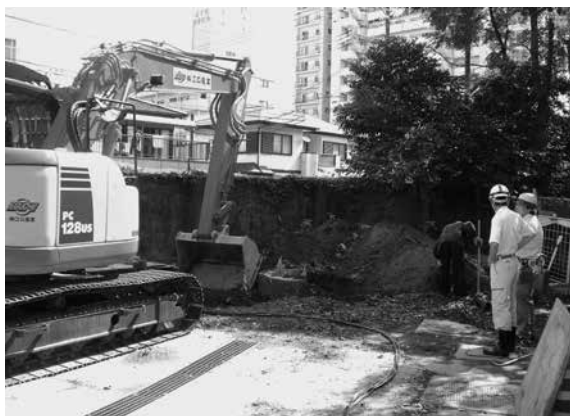
2016-D 掘削状況
