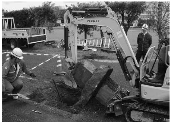
2016-J 掘削状況
