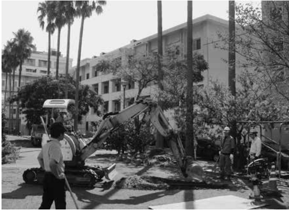
2016-C f地点 掘削状況
