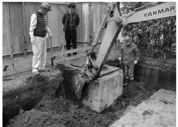
2016-G b 地点掘削状況
