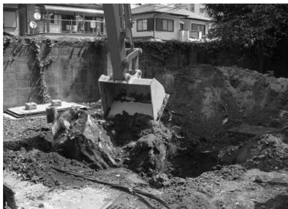
2016-D 掘削状況
