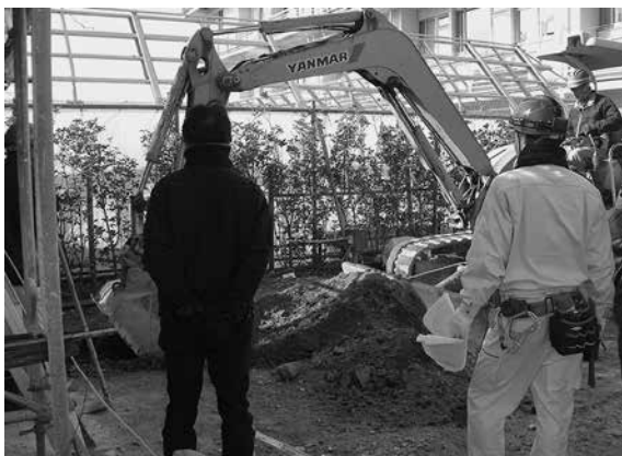
2016-G c 地点掘削状況
