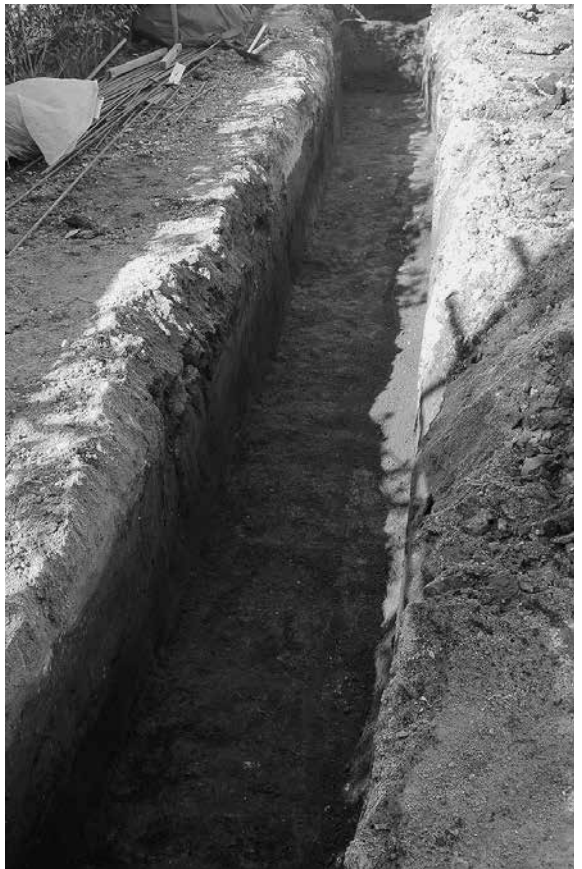
2016-G c 地点掘削状況
