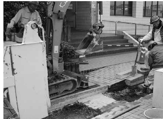
2016-F 掘削状況
