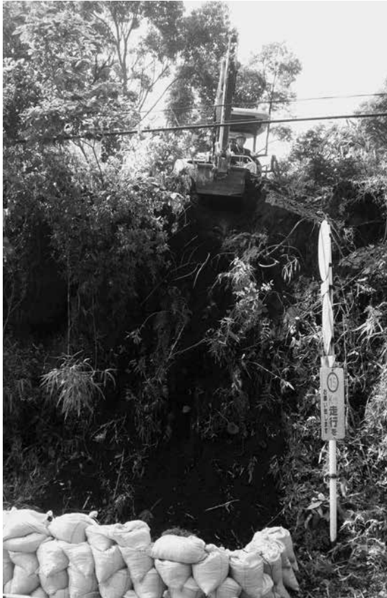
2016-A 崖面掘削作業
