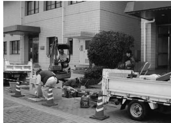
2016-F 掘削状況
