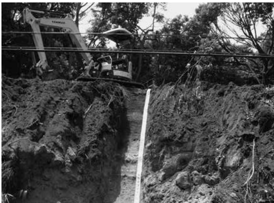
2016-A 土層断面上部
