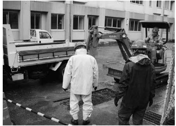
2016-H 掘削状況
