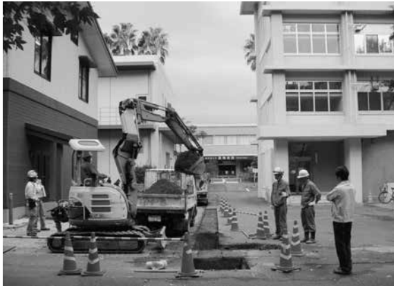
2016-C g地点 掘削状況
