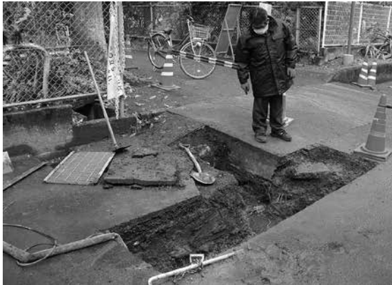
2016-H 掘削状況
