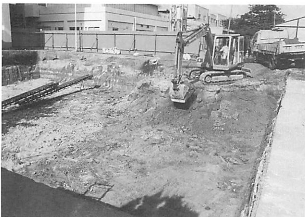
PL.52 重機による 5 層除去の様子
