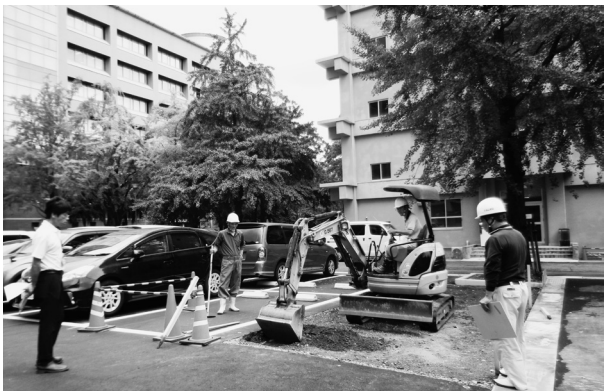
1 調査地点（西より）
