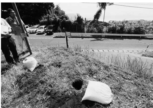
1 a 地点掘削（西より）
