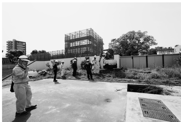
2 b/c地点（北より）手前穴がb地点、後方重機がc地点
