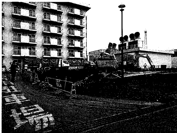
2010-E 擁壁撤去部 南より
