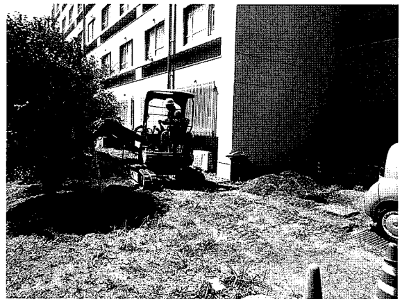
2010-C B地点a・bトレンチ調査風景（東より）
