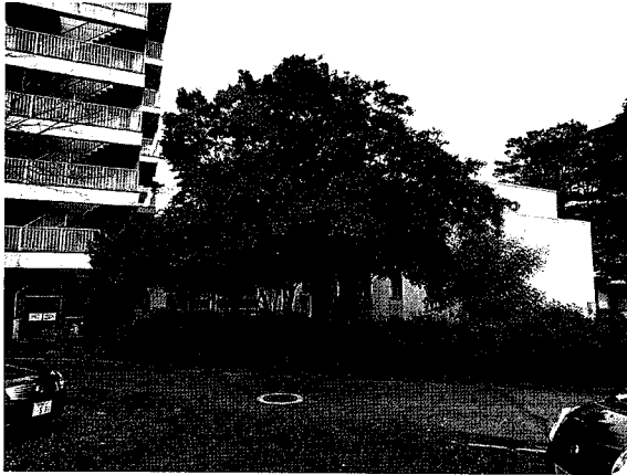
2010-F 工事地点 (西より)
