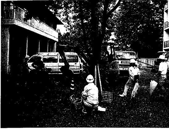
2010-B b トレンチ掘削状況
