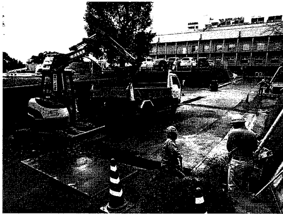
2010-C F地点配水管地点北より
