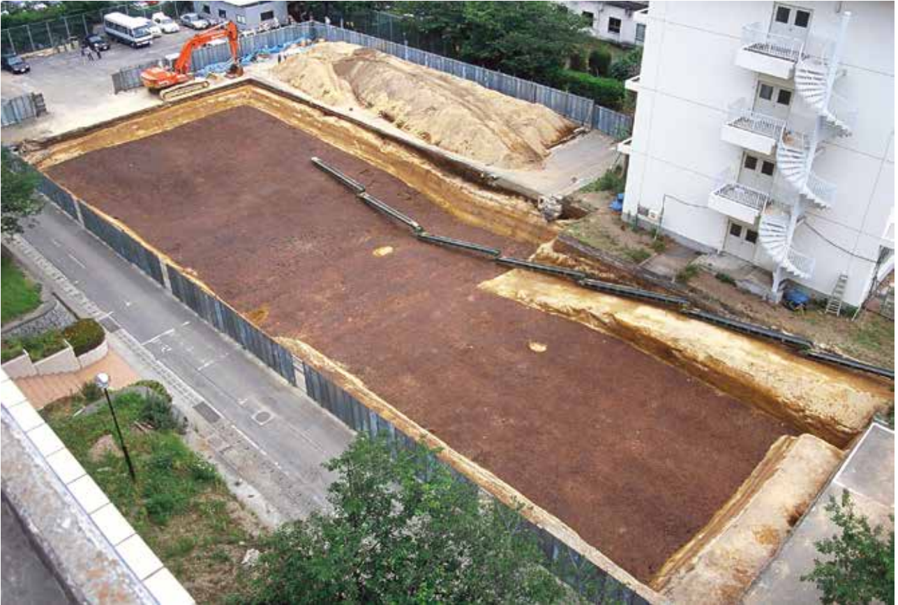
1 2000-2（保健学科棟工事）陥穴検出 共同溝部分は未調査時
