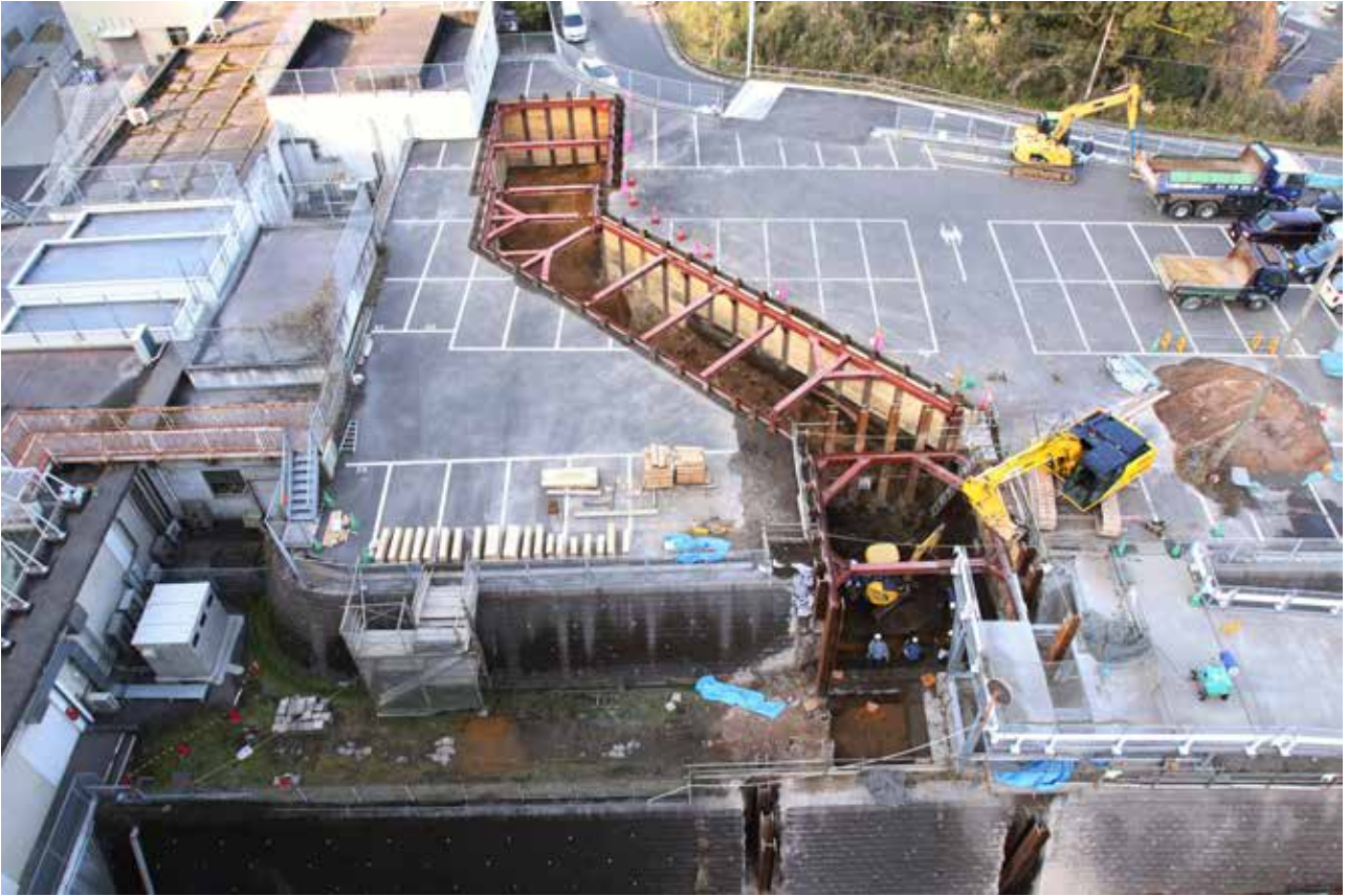
3 2011-3 基盤整備（共同溝）工事 A・B 区
