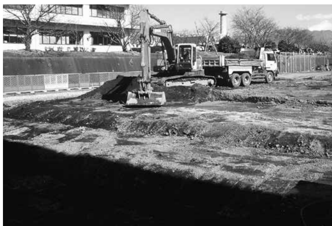
PL.4 表土除去作業
