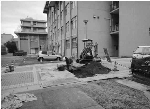
2012-I 9 地点掘削状況
