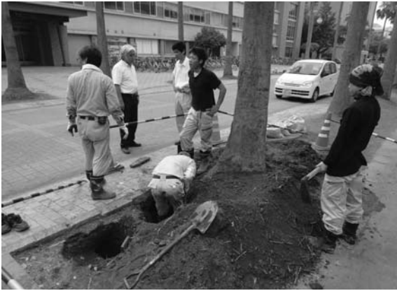
2012-F 掘削状況
