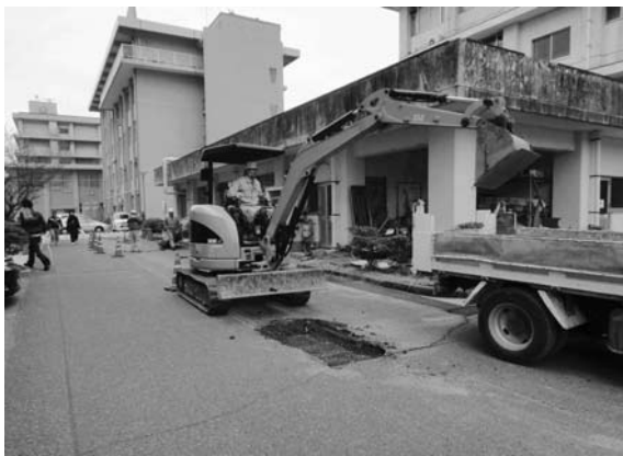
2012-I 6 地点掘削状況
