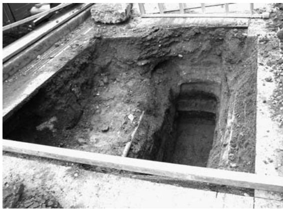
2012-I 2 地点掘削状況
