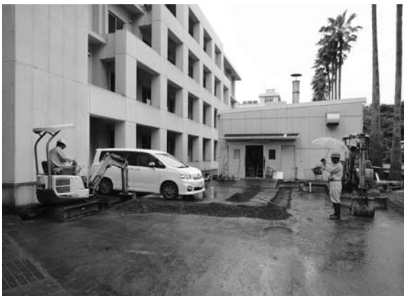
2012-D 掘削状況
