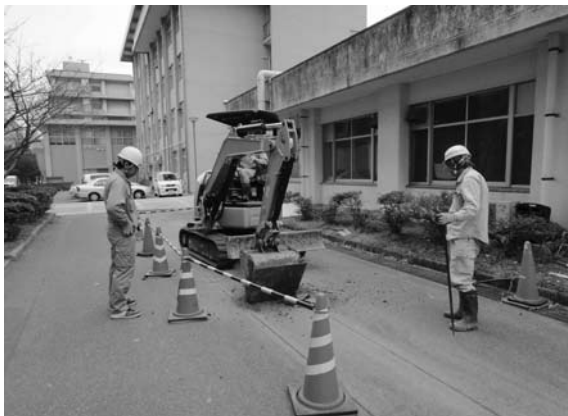
2012-I 7 地点掘削状況
