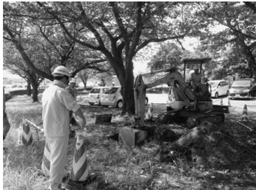
2012-E d 地点掘削状況
