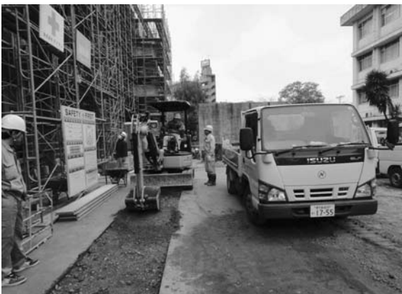
2012-I 3 地点掘削状況
