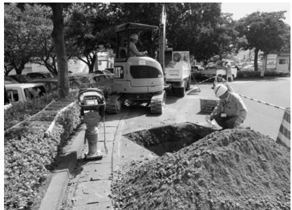
2012-E c 地点掘削状況
