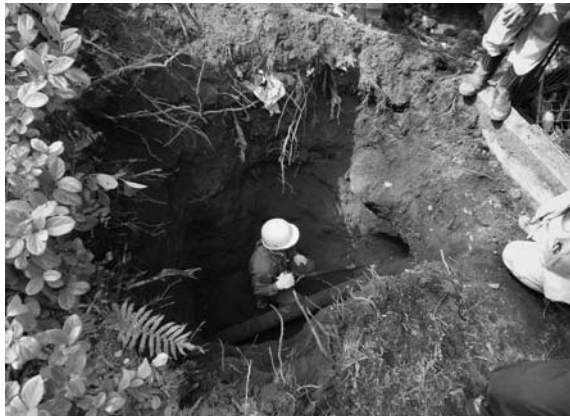
2012-B 東側掘削状況
