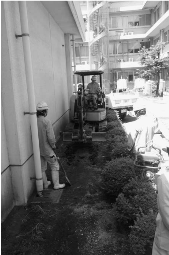
2012-E a 地点掘削状況
