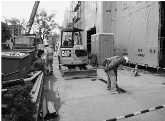
2012-I 2 地点掘削状況
