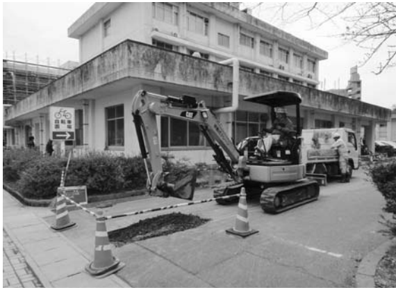
2012-I 8 地点掘削状況
