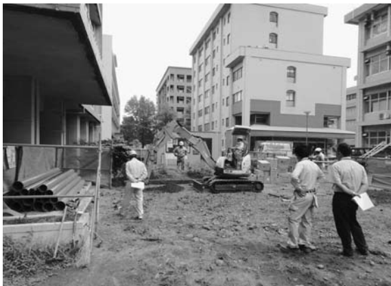
2012-C c 地点掘削状況
