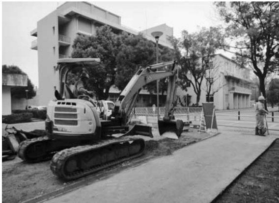
2012-J d 地点掘削状況
