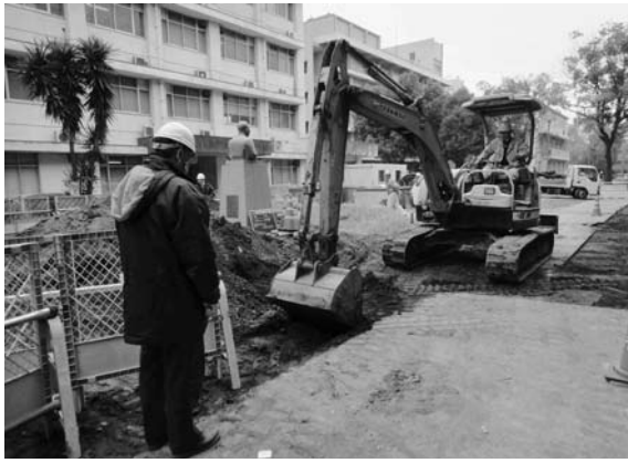
2012-J c 地点掘削状況
