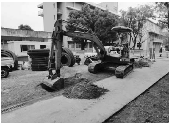
2012-J e 地点掘削状況
