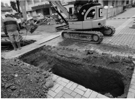
2012-I 4 地点掘削状況
