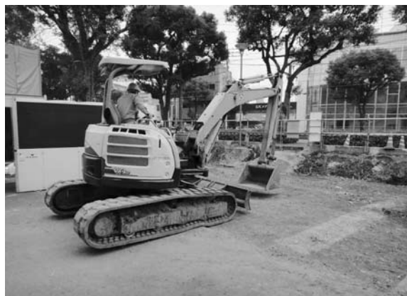
2012-J a 地点掘削状況
