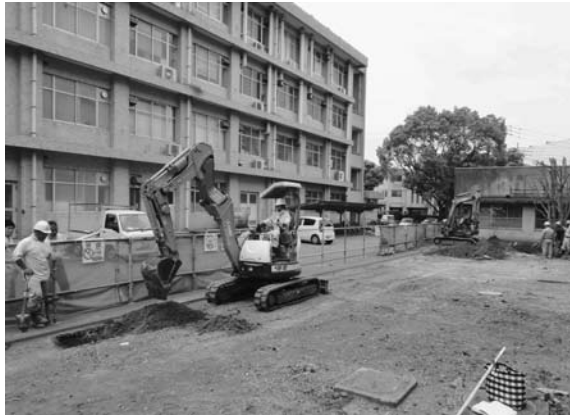
2012-C b 地点掘削状況 北東より
