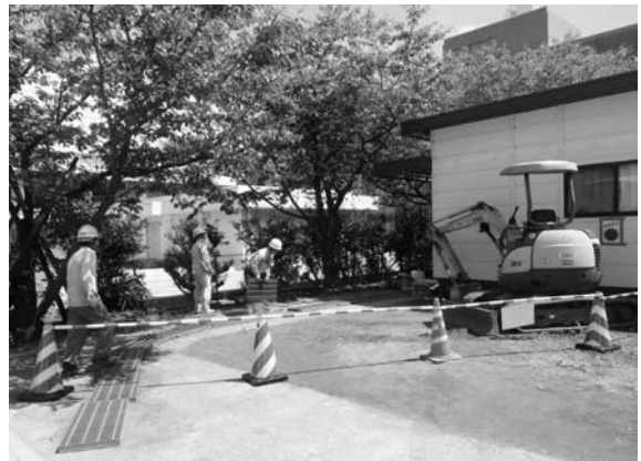
2012-E b 地点掘削状況
