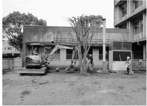
2012-C e 地点掘削状況 東より
