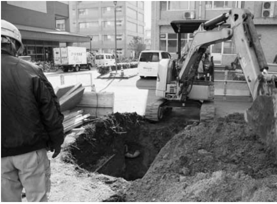
2012-I 1 地点掘削状況
