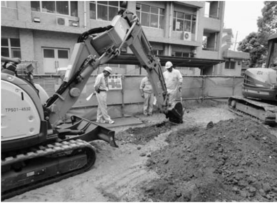
2012-C a 地点掘削状況 北東より
