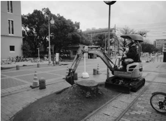
2012-G 掘削状況
