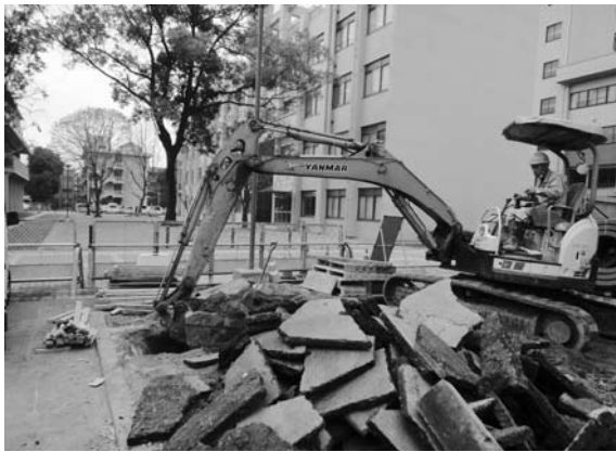
2012-I 5 地点掘削状況
