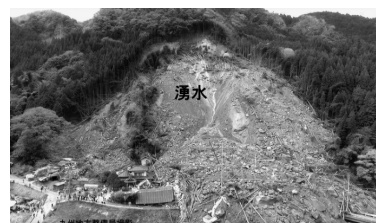
図2 2018年に大分県耶馬溪町で発生した大規模崩壊
