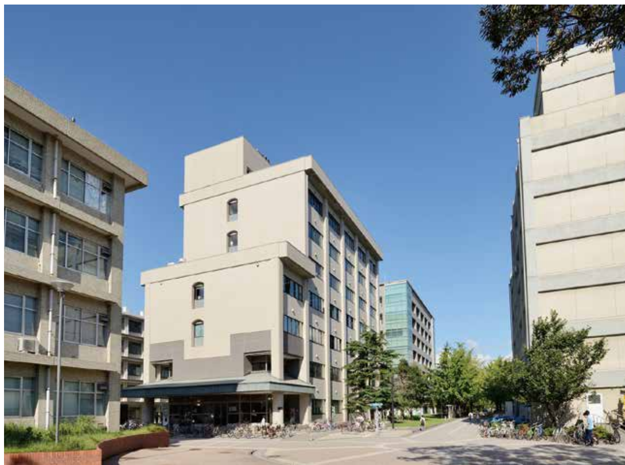
左側の建物：化学生命工学科棟(旧応用化学工学科2号棟)、中央の建物：工学部共通棟 右側の建物：海洋土木工学科棟(改修中：平成30年5月現在)
