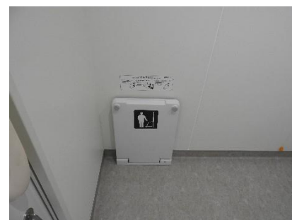
1階みんなのトイレ内 フィッティングボード
