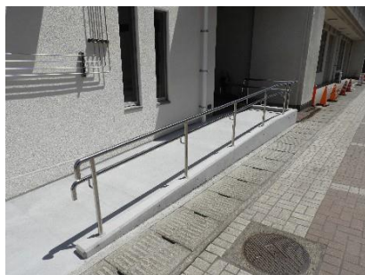
正面スロープ
