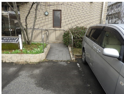
正面玄関スロープ
