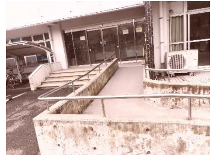
正面玄関スロープ
