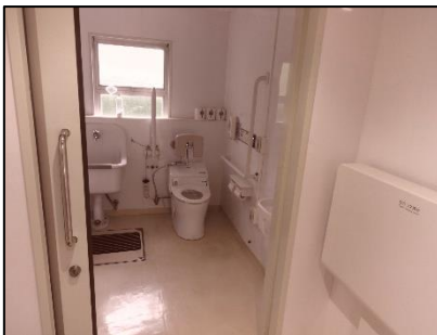
1階福祉型男性トイレ 入口
