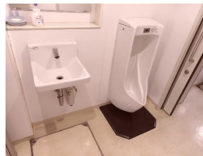
1階福祉型男性トイレ 小便器
