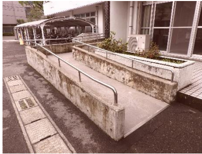
正面玄関スロープ
