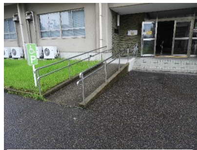
正面玄関スロープ
