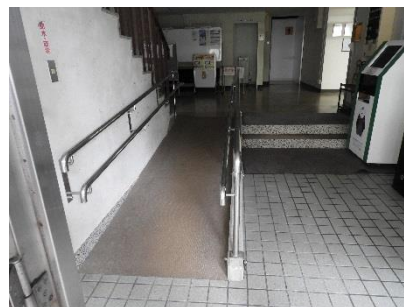
正面玄関内スロープ
