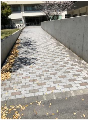
正面スロープ
