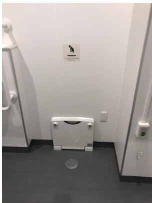
1.4階女子福祉型トイレ内 フィッティングボード
