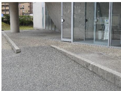
正面玄関スロープ
