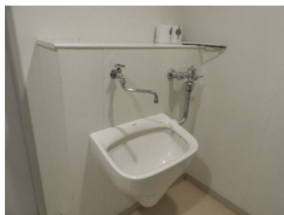
1階みんなのトイレ 個室内オストメイト
