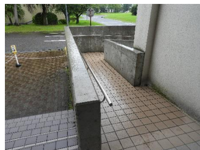
正面玄関スロープ
