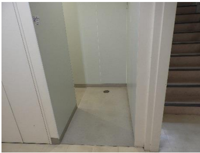
1階男子トイレ入口
