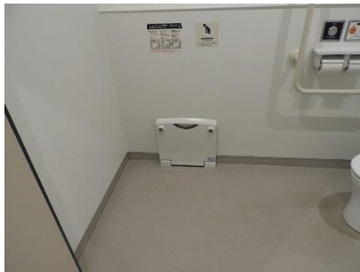
2階女子トイレ内 フィッティングボード
