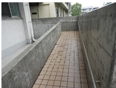
正面玄関スロープ
