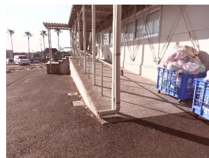
建物裏スロープ
