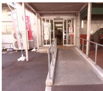
正面スロープ
