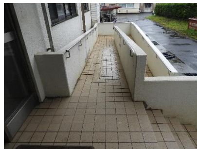
裏入口玄関前スロープ
