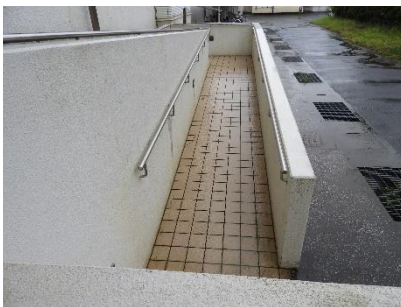
裏入口玄関前スロープ
