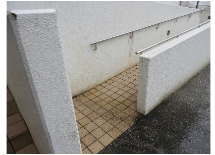
裏入口玄関前スロープ
