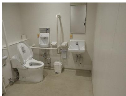
1階みんなのトイレ個室 手洗い
