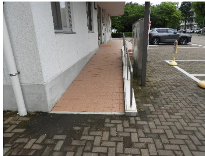
正面玄関スロープ
