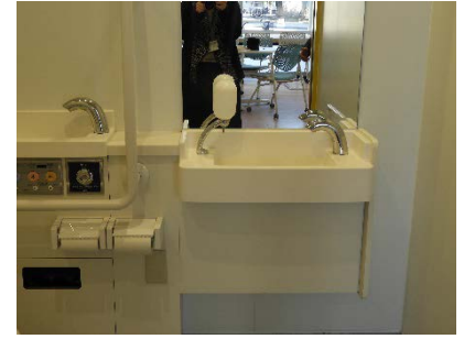
1階みんなのトイレ個室手洗い
