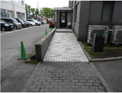
正面玄関スロープ
