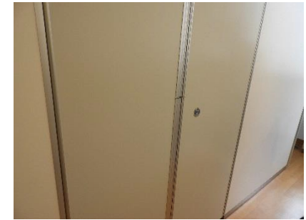
2階男子多目的トイレドア
