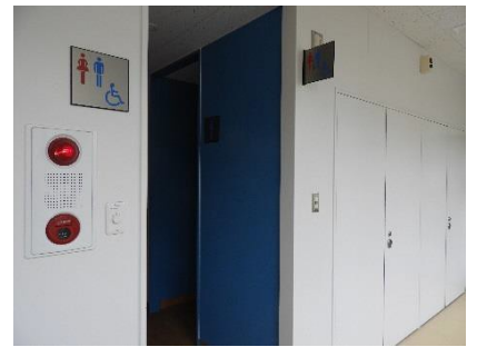
2階男女別トイレ入口
