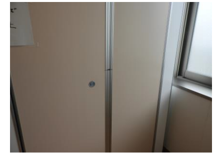
2階女子多目的トイレドア
