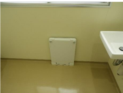
1階みんなのトイレ個室 フィッティングボード
