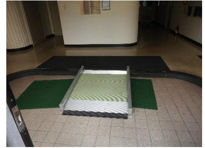
正面玄関内スロープ
